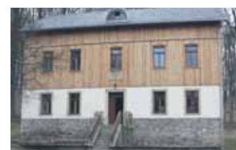
Das Huthaus wurde in den vergangenen Jahren aufwendig saniert.
