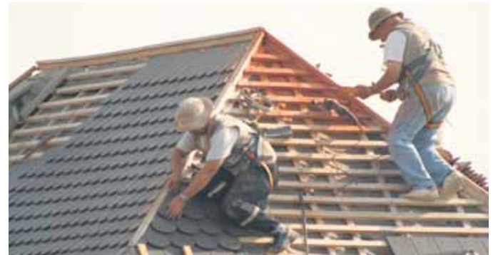
Nach der Notsicherung geht es jetzt ans Decken der Dächer.
