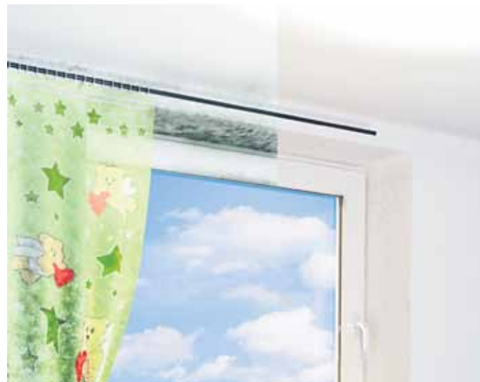
Eine richtige Lüftung kann Schimmel vermeiden.
