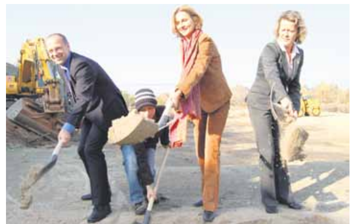
Baustart mit vier Spaten: Die symbolischen ersten Spatenstiche vollzogen Geschäftsführerin Irene Petrovic-Wettstädt, Schulleiterin Kathrin Mayer, Schüler Brandon Schramm und Bürgermeister Uwe Herrmann (von rechts). Foto: Roger Dietze
